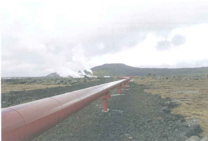
Geothermische energie stroomt door een pijpleiding.
